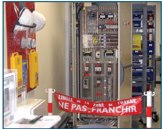
En habilitations électriques (armoires et équipements de protection) permettent une mise en situation pratique.
